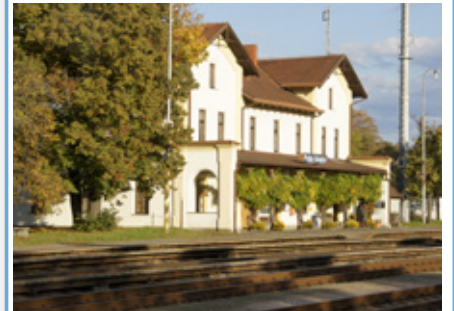
9. V roce 2000 se ušmudlaná nádražní budova proměnila v příjemnou a hezkou budovu, která je zapsána do seznamu kulturních památek.
