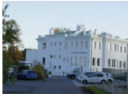
8. Celkovou rekonstrukcí prošla i bývalá budova rádiové stanice. Od září tohoto roku je v této budově umístěno 1. IT Gymnázium.
